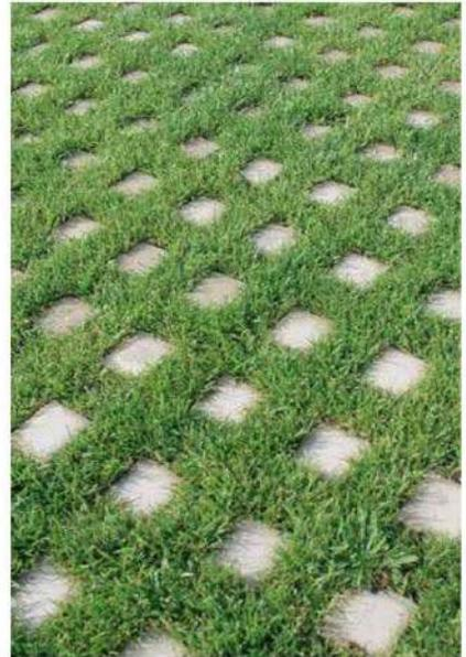
Diverse tipologie di pavimentazioni drenanti che garantiscono un'infiltrazione parziale a confronto: asfalto o calcestruzzo poroso, allettamento masselli con materiale permeabile e ghiaia rinverdito o sterrato.
